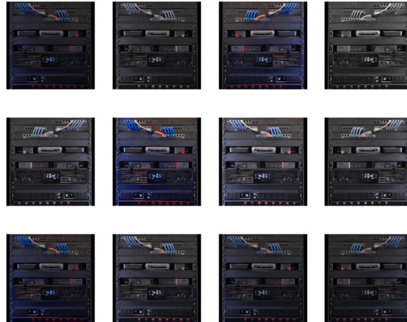
Abbildung 5.8: Visualisierung der Augmentationen für das Training von YOLO durch die „Augmentations-Pipeline“ auf das Rack der exemplarischen Steckplatzanalyse
